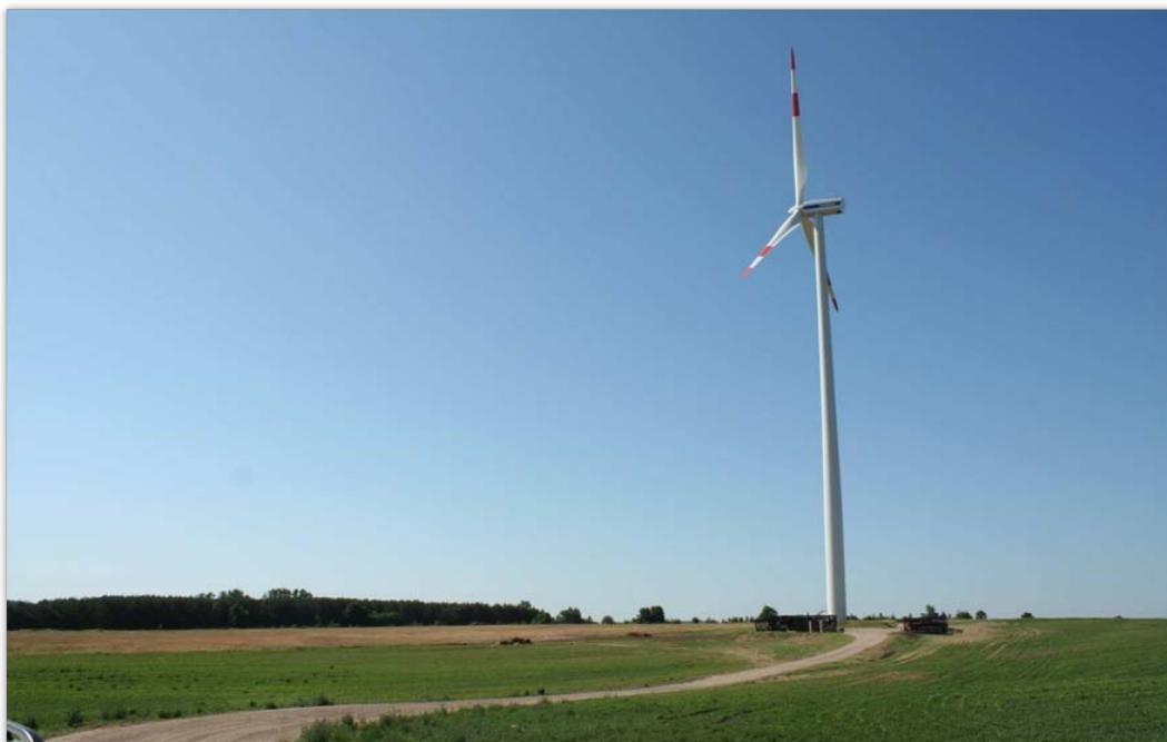
Wittstock-Pampenbruch, Vestas V90, 2MW
